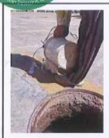
生活污水排放口
