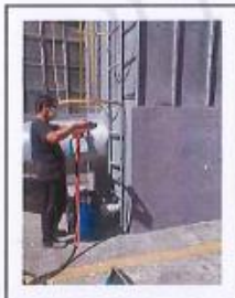
喷底漆、面漆、自然晾干、 漆磨工序废气处理前
